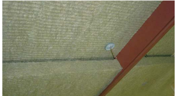
2 x 50 мм ROCKWOOL SeaRox SL 340 с зазором 10 мм при проверке уменьшения уровня шума
